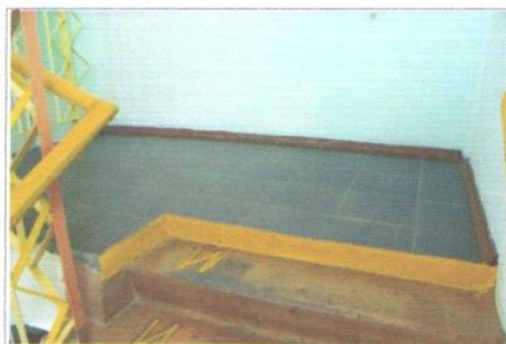
Фото № 37 – Лестница (внутри здания)
