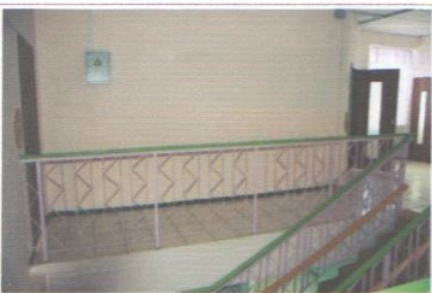
Фото № 40– Лестница (внутри здания)
