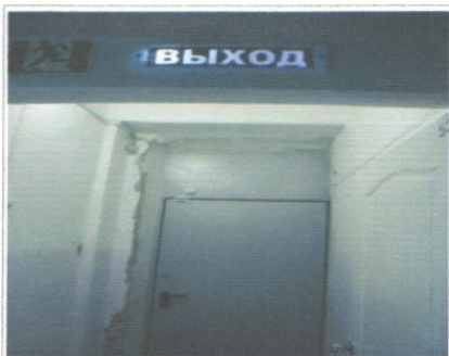
Фото № 44- Пути эвакуации (в том числе зоны безопасности)
