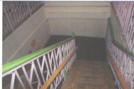
Фото № 39 – Лестница (внутри здания)
