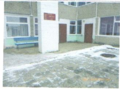
Фото № 14 – Площадка перед входом
