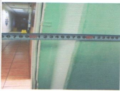
Фото № 28- Дверь внутри здания
