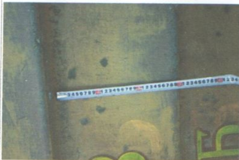
Фото № 34 – Лестница (внутри здания)
