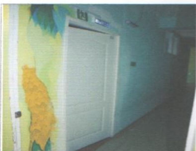
Фото № 42- Пути эвакуации (в том числе зоны безопасности)
