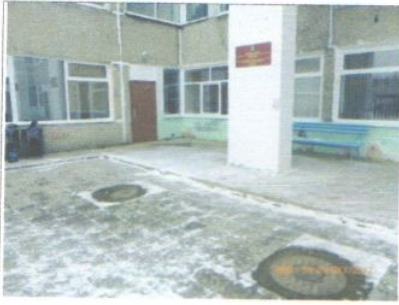
Фото № 13 – Площадка перед входом
