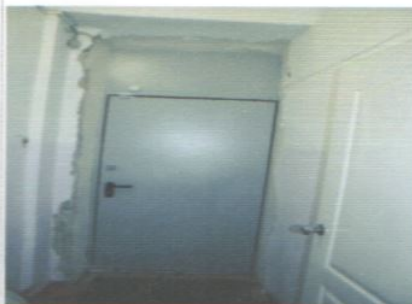
Фото № 43- Пути эвакуации (в том числе зоны безопасности)
