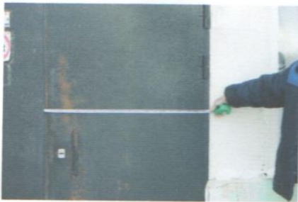
Фото № 17- Дверь (входная)
