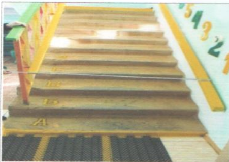
Фото № 32 – Лестница (внутри здания)
