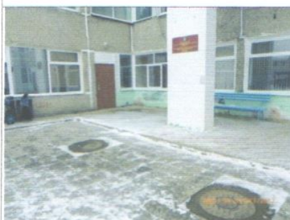
Фото № 47 Пути эвакуации (в том числе зоны безопасности)
