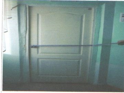
Фото № 29- Дверь внутри здания
