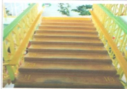
Фото № 33 – Лестница (внутри здания)
