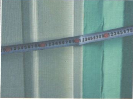
Фото № 30- Дверь внутри здания
