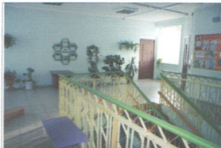
Фото № 41 – Лестница (внутри здания)
