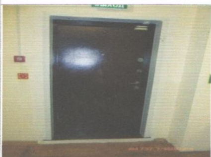
Фото № 46- Пути эвакуации (в том числе зоны безопасности)
