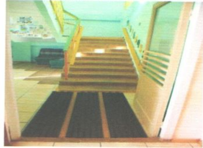
Фото № 31 – Лестница (внутри здания)
