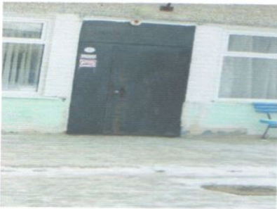
Фото № 15- Дверь (входная)
