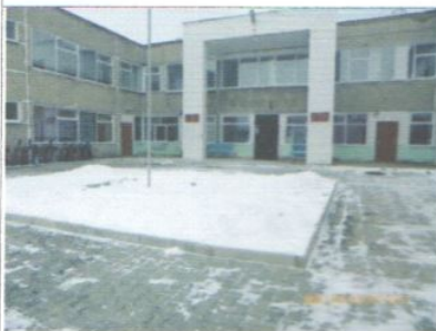
Фото № 11 –Вход в здание
